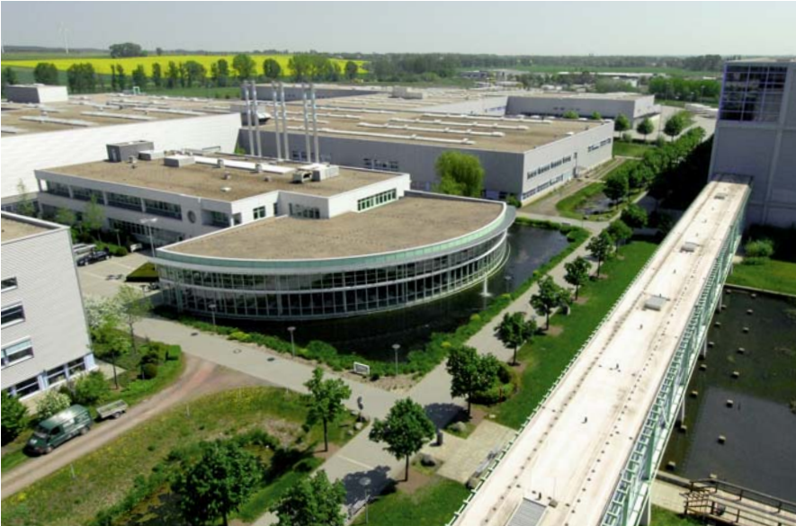
Industriearchitektur vom Feinsten - Versandzentrum Haldensleben der Hermes Warehousing Solutions
